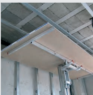
Montaż płyt kartonowo-gipsowych Installing plasterboard panels
