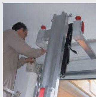
Montaż żaluzji Installing shutters
